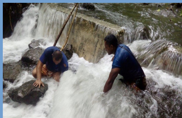
Travaux sur le réseau routier et eau à Futuna
